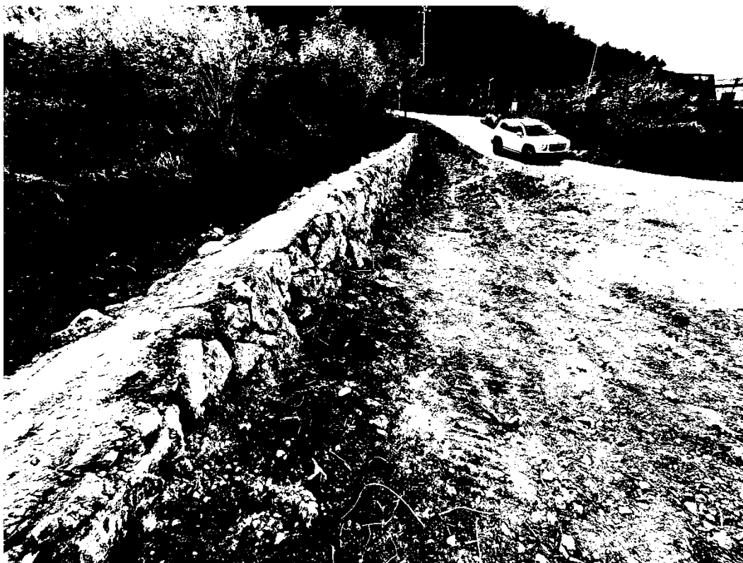
图 2-11 废石场坡脚设置浆砌石挡墙
